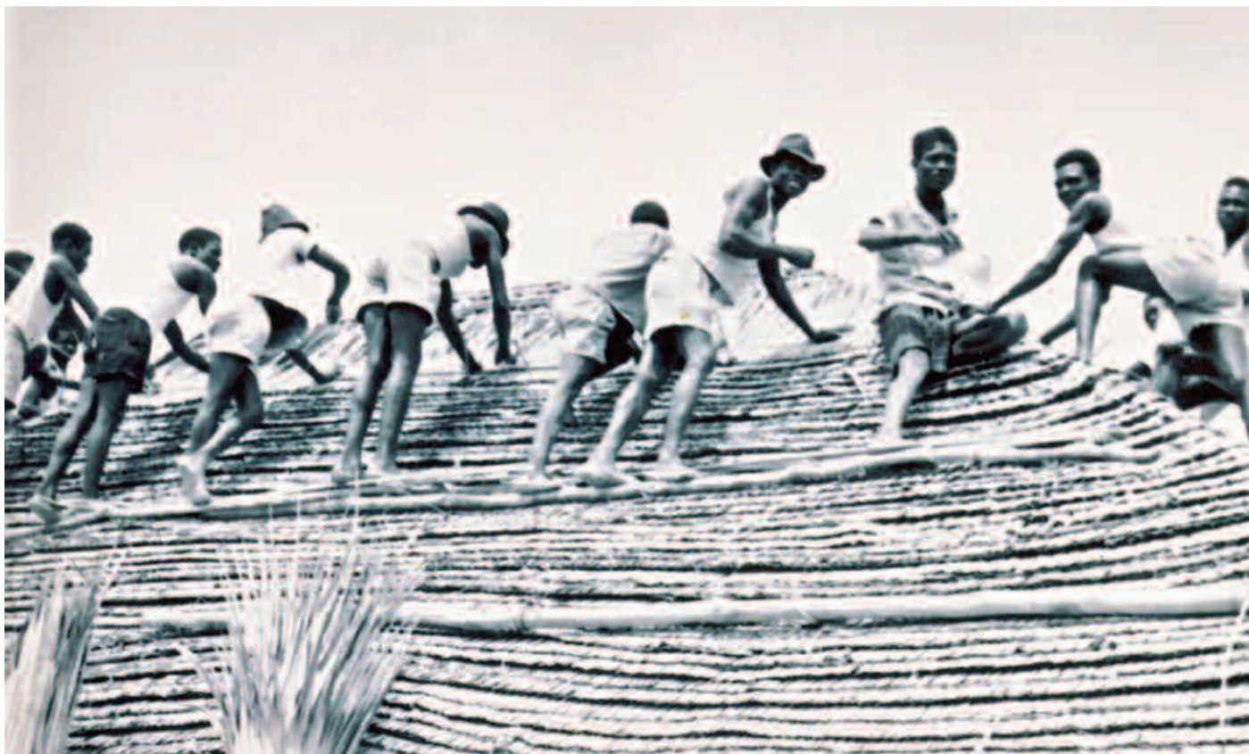
La construction d'une maison est une tâche collective qui rassemble plusieurs hommes du clan ou du village. Ils achèvent ici de couvrir le toit de feuilles ndala (folioles d'un palmier de la forêt). Village Pumbi, en bordure du Kasai, nord du Territoire d'Idiofa (photo Henri Nicolai, 1955/40).
