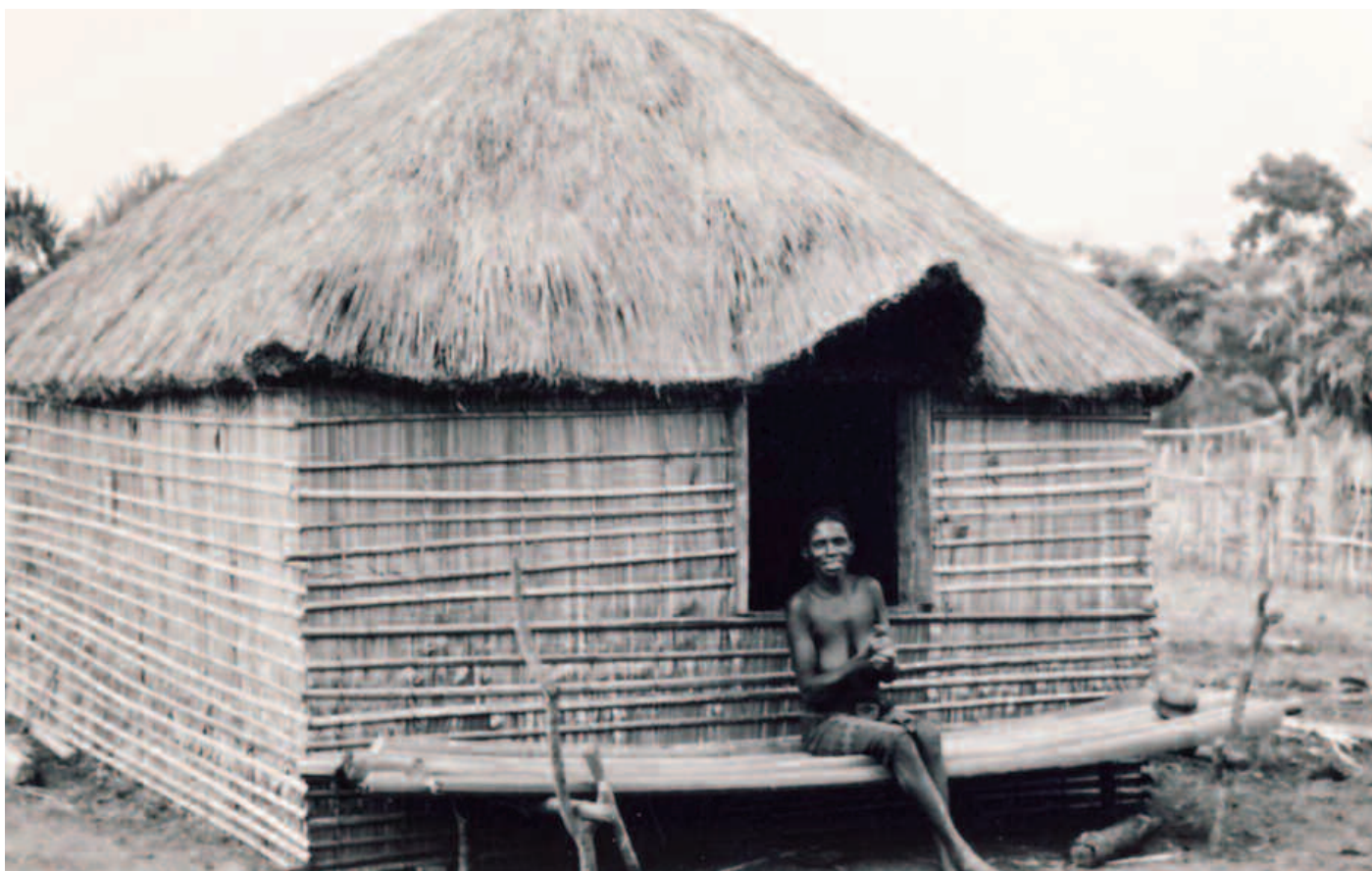
Cette maison mbunda ( Ifwazondo, T.d'Idiofa ), aux parois renforcées par un treillis de lattes, a un toit de paille qui ressemble à la coupole de la maison pende. Un arceau du toit se prolonge en auvent au-dessus de la porte-fenêtre. Une photo d'une maison très semblable, du milieu de la première décennie du XIXe siècle, figure dans un ouvrage de Torday et Joyce de 1922 (pl. XV) ( photo Henri Nicolai, 1955/34 ).
