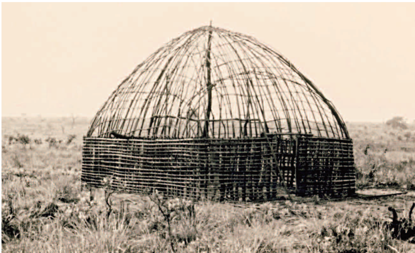
Légèreté de l'armature d'un toit en coupole. Village pende de Kimbanzi ( photo Henri Nicolai, 1957/18 ).
